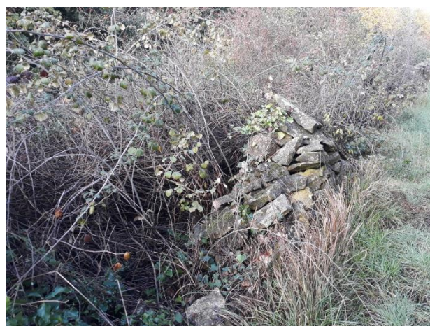
Urušeni suhozid na istočnoj međi
